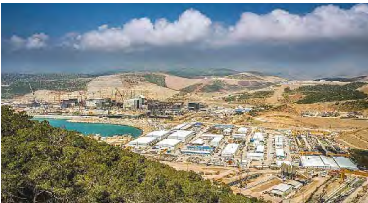
Рисунок 1. Будівництво АЕС «Аккую» (Туреччина), на якій впроваджується автоматизована система безперервного моніторингу хімічних показників охолоджувальної води, що скидається в море [9]
